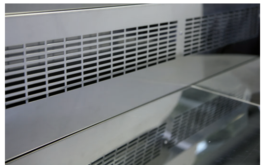
Sopra: Lama Mandata dell'aria. Sotto: Griglia Ripresa dell'aria.
